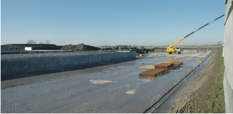
De bouw van de nieuwe stallen aan de Ivige Leane is inmiddels in volle gang.
