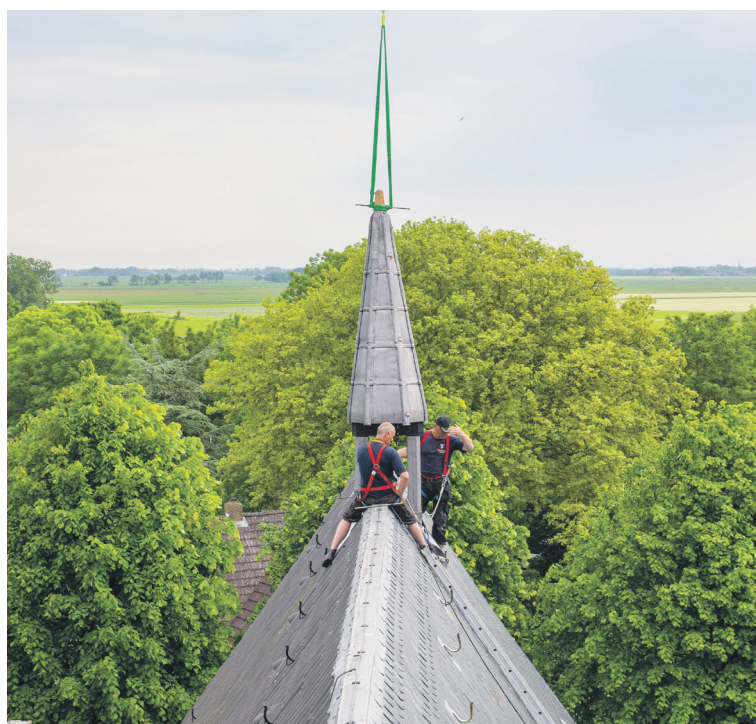
Ed Hankel en Willem de Boer op de nok van het dak bezig met het monteren van het Angelusklokje. Foto: Jaap Bonhof.
